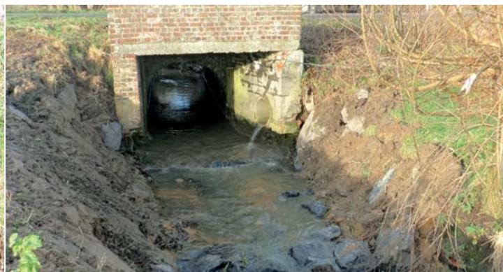
Mise en place d'un seuil de fond sur l'Esperlion afin de limiter l'enfoncement du lit / Avant et après
