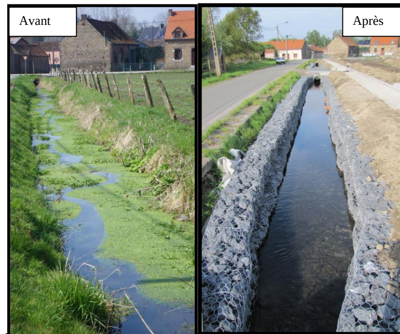
Aménagement de cours d'eau pour la construction d'un lotissement
