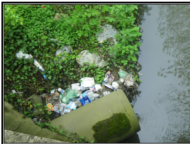
Dépôt de déchet sauvage
