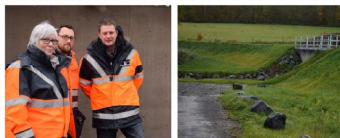
En cas d'afflux des eaux, celles-ci sont stockées dans un ouvrage limitant.
